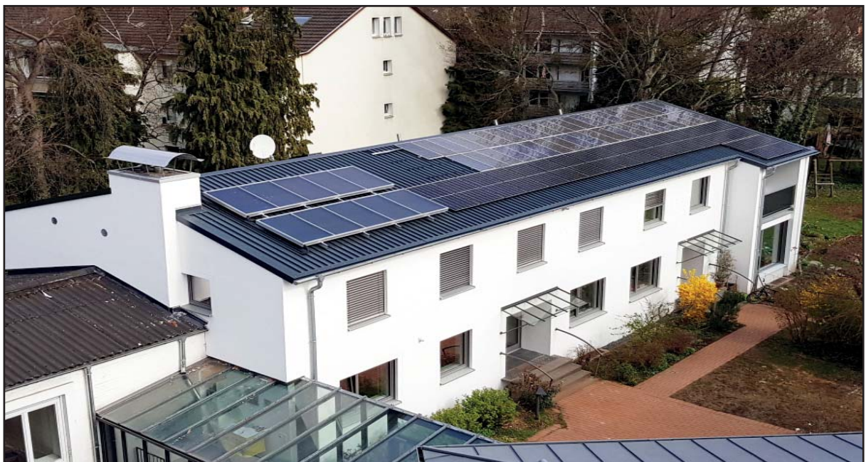
Auf dem Pfarrhaus mit Küsterwohnung und Gemeinderäumen erzeugt die Sonne in zwei Fotovoltaikanlagen und einer Solarthermie Strom und warmes Wasser.
