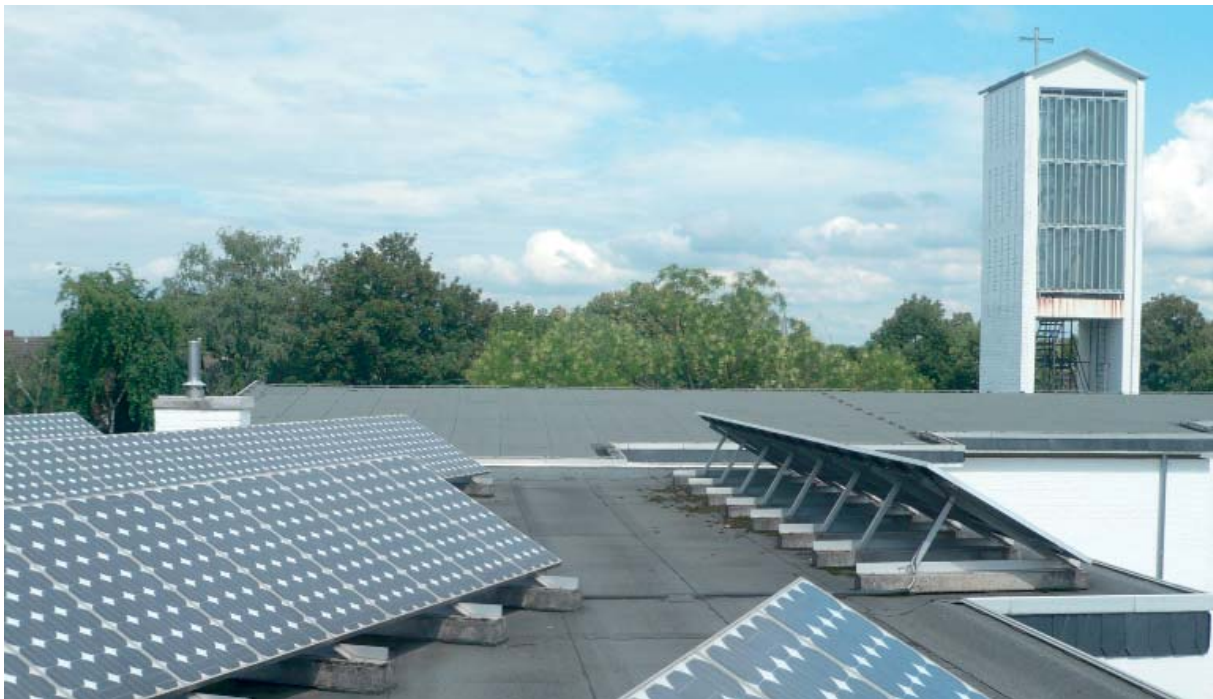
Seit Mitte der 1990er Jahre kann die Gemeinde Sonnenenergie in das öffentliche Netz einspeisen. Diese Anlage befindet sich auf dem Dach des Wohnhauses Brahmsstraße 18
